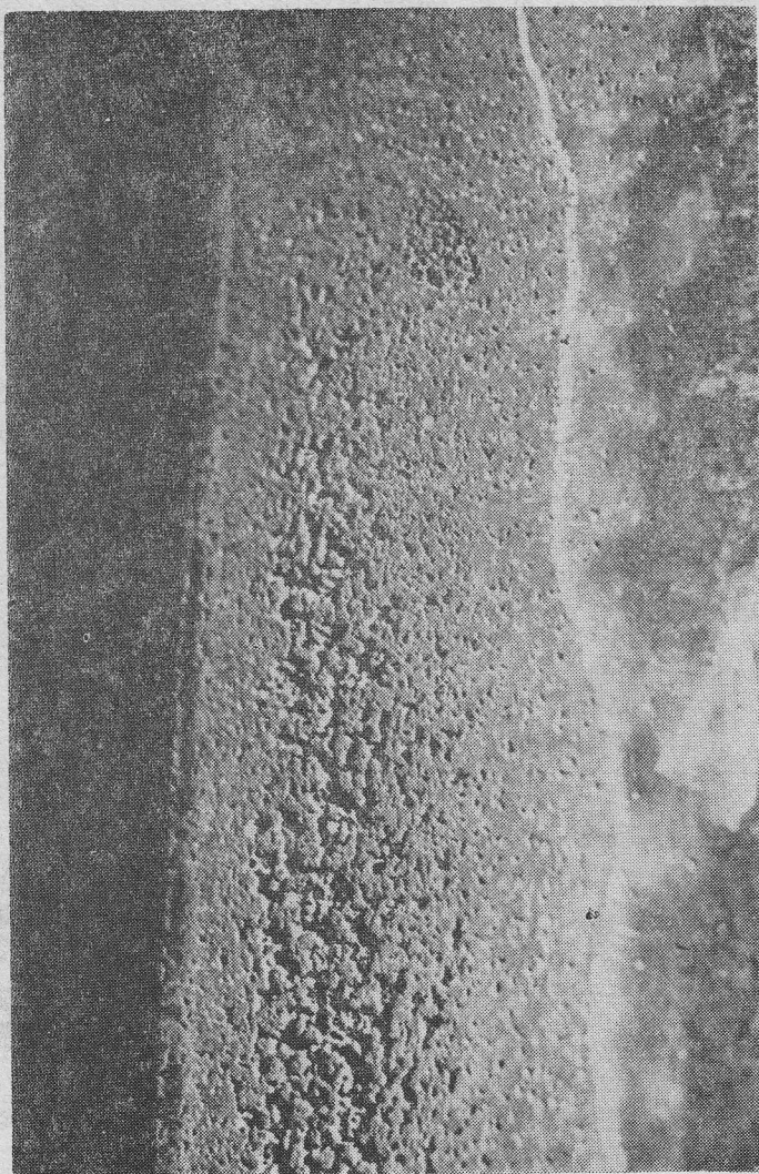
Rys. 4. Fotografia łopatki kierownicy ze śladami erozji kawitacyjnej
