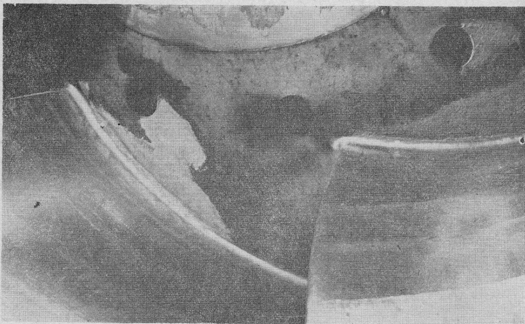
Rys. 17. Powierzchnia płyty wirnika maszyny odwracalnej po wykonanej naprawie uszkodzeń kawitacyjnych za pomocą żywic epoksydowych
