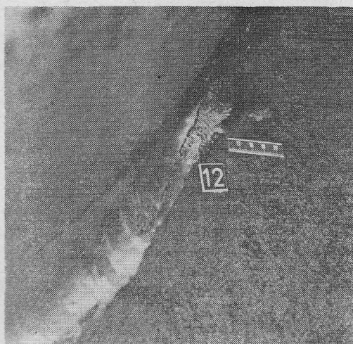
Rys. 6. Kawitacja dolnej krawędzi łopaty wirnikowej turbiny 40 MW
