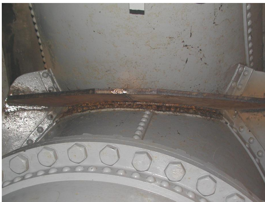
Żebro wzmacniające rozgałęzienie rurociągu
