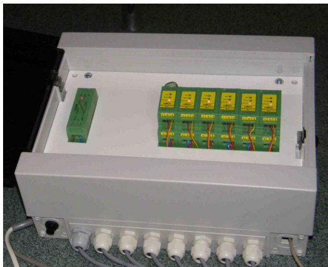
Moduł akwizycji danych pomiarowych (karta pomiarowa i separatory analogowe)
