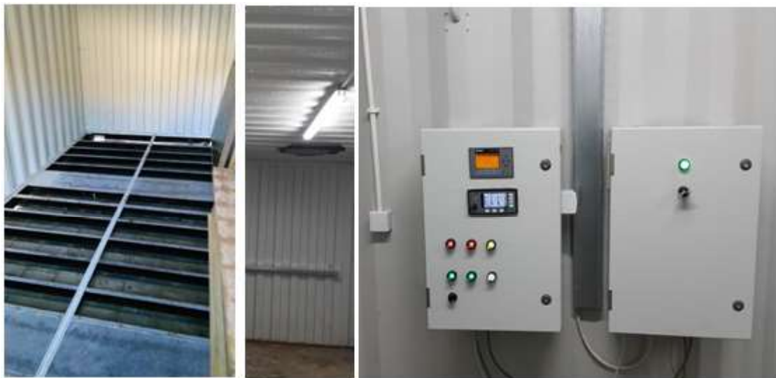
Rys. 11 Montaż podłogi oraz instalacji elektrycznej Rys. 12 Układ kontroli i sterowania instalacją zgazowania
