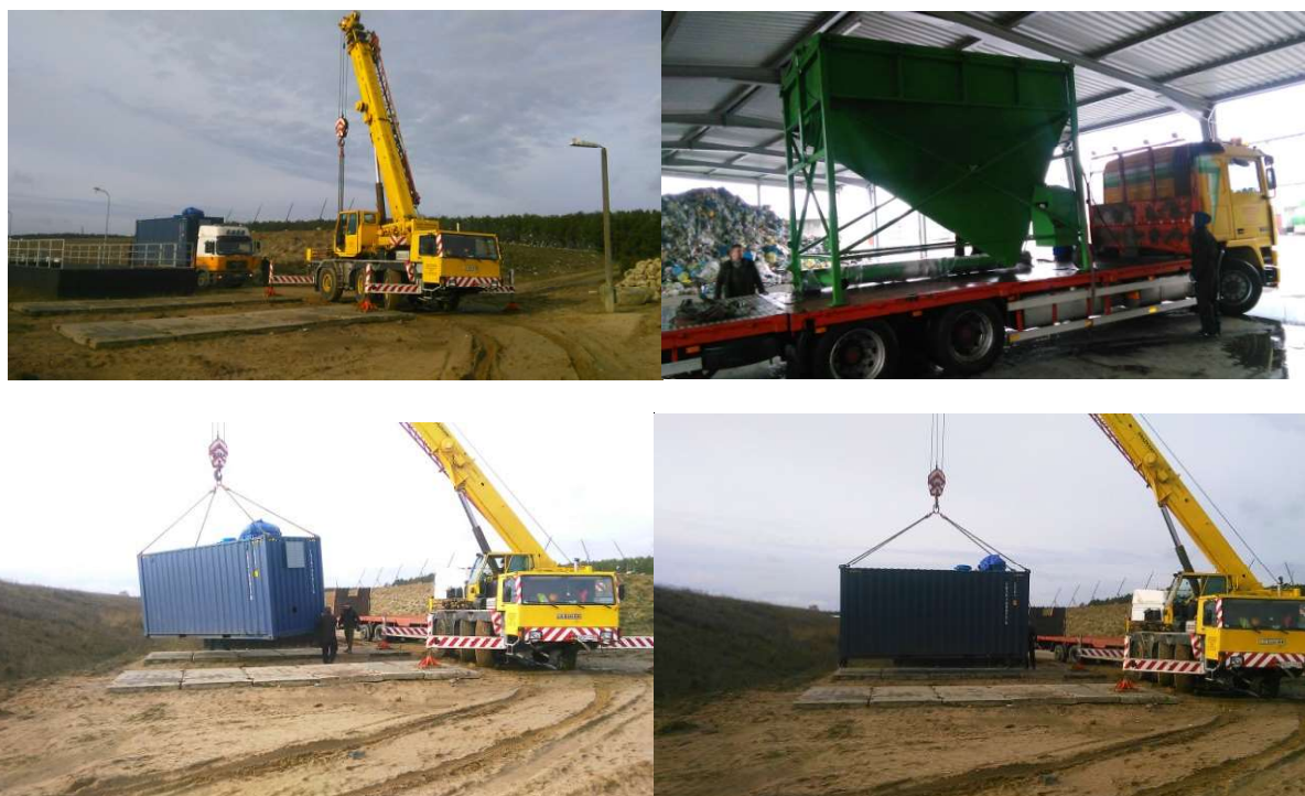
Rys. 17 Montaż instalacji zgazowania odpadów komunalnych w ZZO Nowy Dwór
