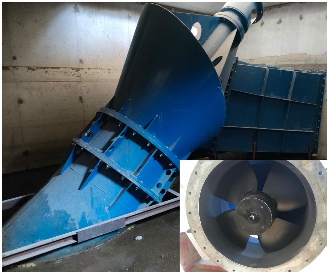
Rys.4.3. Prototyp turbiny semi-Kaplana o mocy ~30 kW zainstalowanej w Elektrowni Wodnej Żagań-Papiernia.
