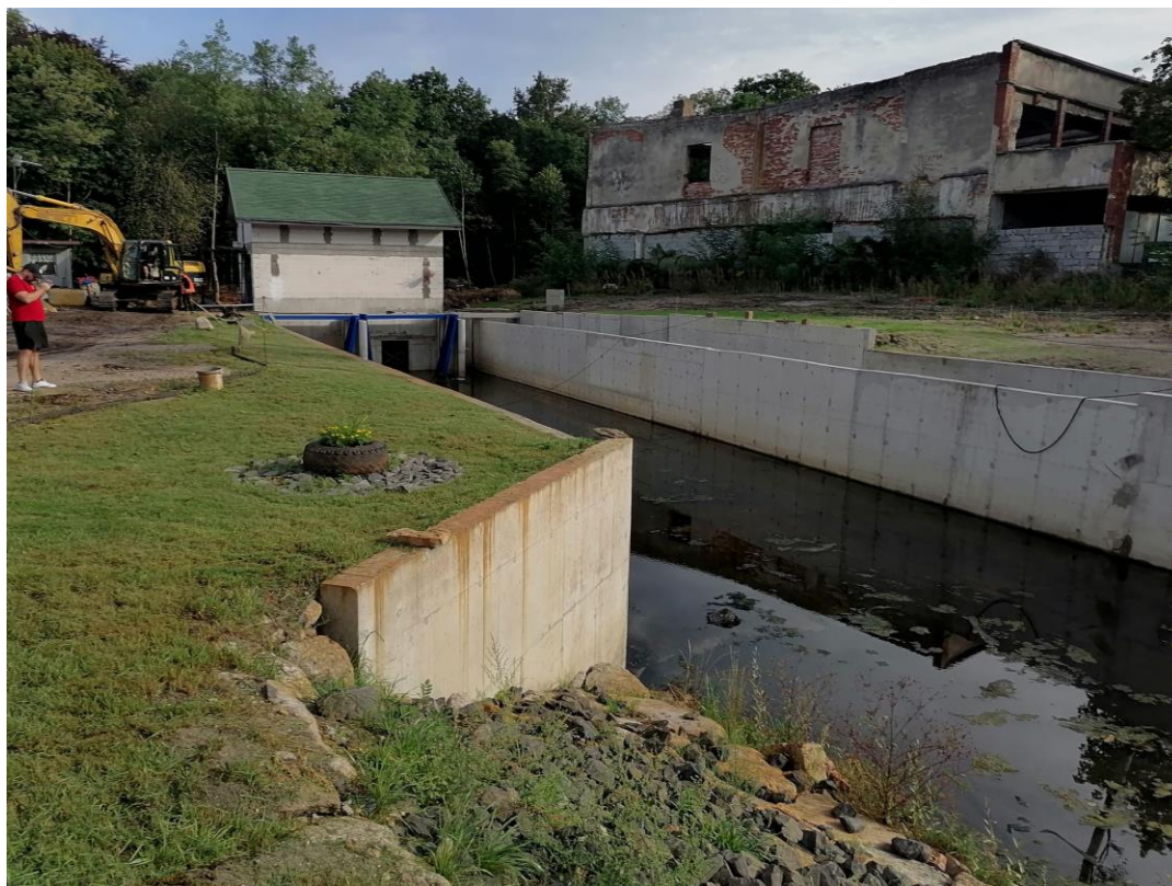
Rys.4.1. Nowopowstała Elektrownia Wodna Żagań-Papiernia (2025) o mocy około 60 kW, należąca do AQUA-Tech sp. z o.o. z Trzebinia.
