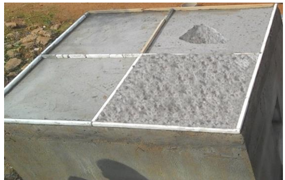
Fig. 8. Fly ash roof slab.
